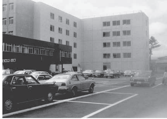
完成した 病棟（南病棟）
