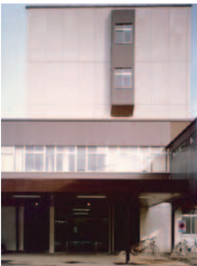
真西から新病院玄関を望む
