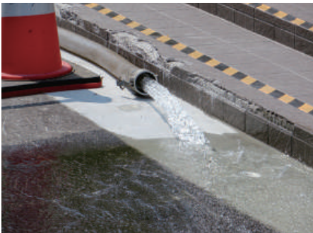
掘削した井戸から出る地下水
