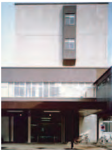
真西から新病院玄関を望む
