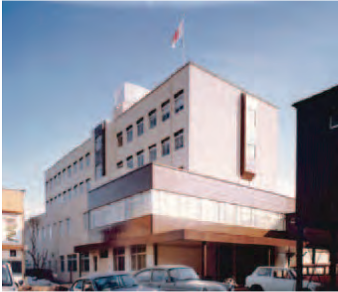
正面玄関（県道287号線=長井街道から望む）
