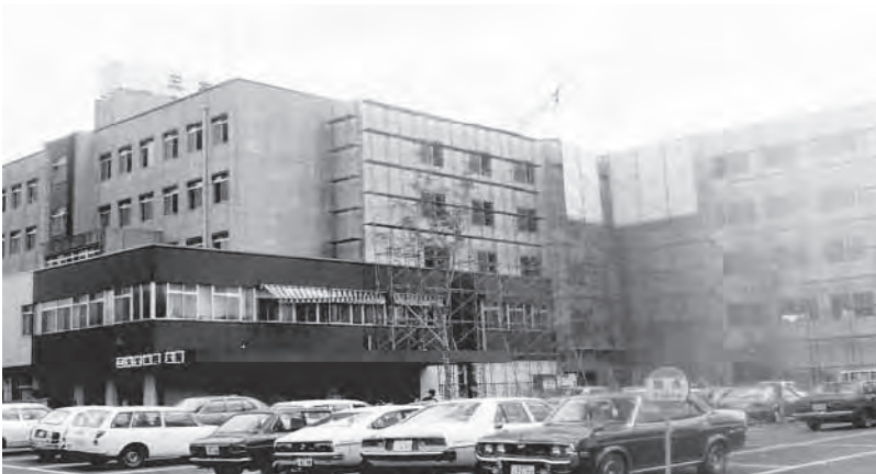
右側奥の病棟 工事風景
